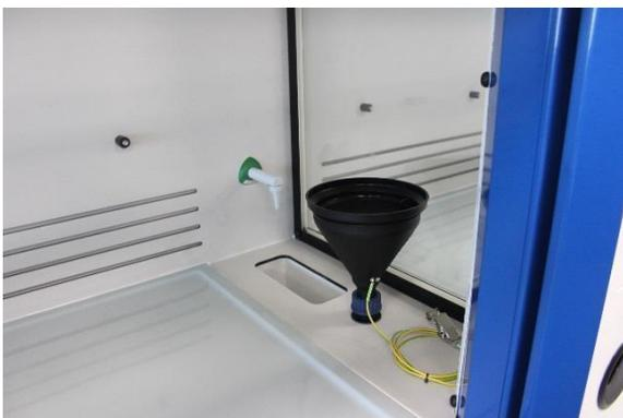
Il dispositivo di scarico controllato prevede uno scarico separato con una vasca di raccolta in materiale antiacido. Il serbatoio può essere dotato di un sensore elettronico di troppo pieno con allarme sonoro.
