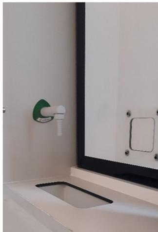
L'acqua di servizio viene fornita completa di vaschetta in PP sigillata nel pianetto dx e crea continuità con il piano di lavoro.
