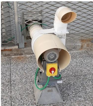
I motori utilizzati per assicurare la miglior aspirazione e la miglior resistenza alle sostanze chimiche sono elettro aspiratori realizzati completamente in polipropilene stampati completamente ad iniezione.
